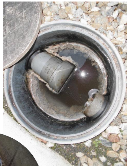
A キッチンからの排水が溜まる 防油マス
